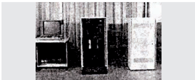
Obr. 2 Na tomto historickom (prevzatom) obrázku je minimálna konfigurácia distribuovaného mikropočítačového riadiaceho systému SMEP SM 53/10. Vpravo je terminál styku s prostredím, v strede terminál operátora procesu a vľavo operátorský pult s farebným semigrafickým displejom a operátorskou klávesnicou.
